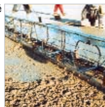
Un seul passage pour vibrer, araser et niveller
