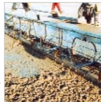
Vibración, nivelado y corte de una pasada.
